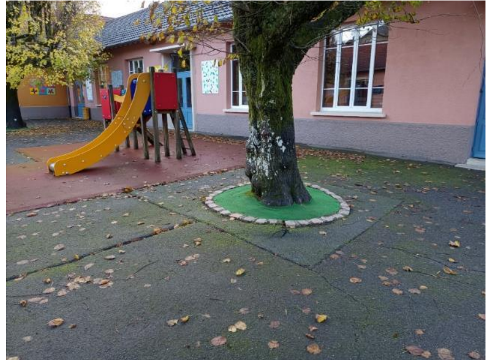
Photo avant les travaux
