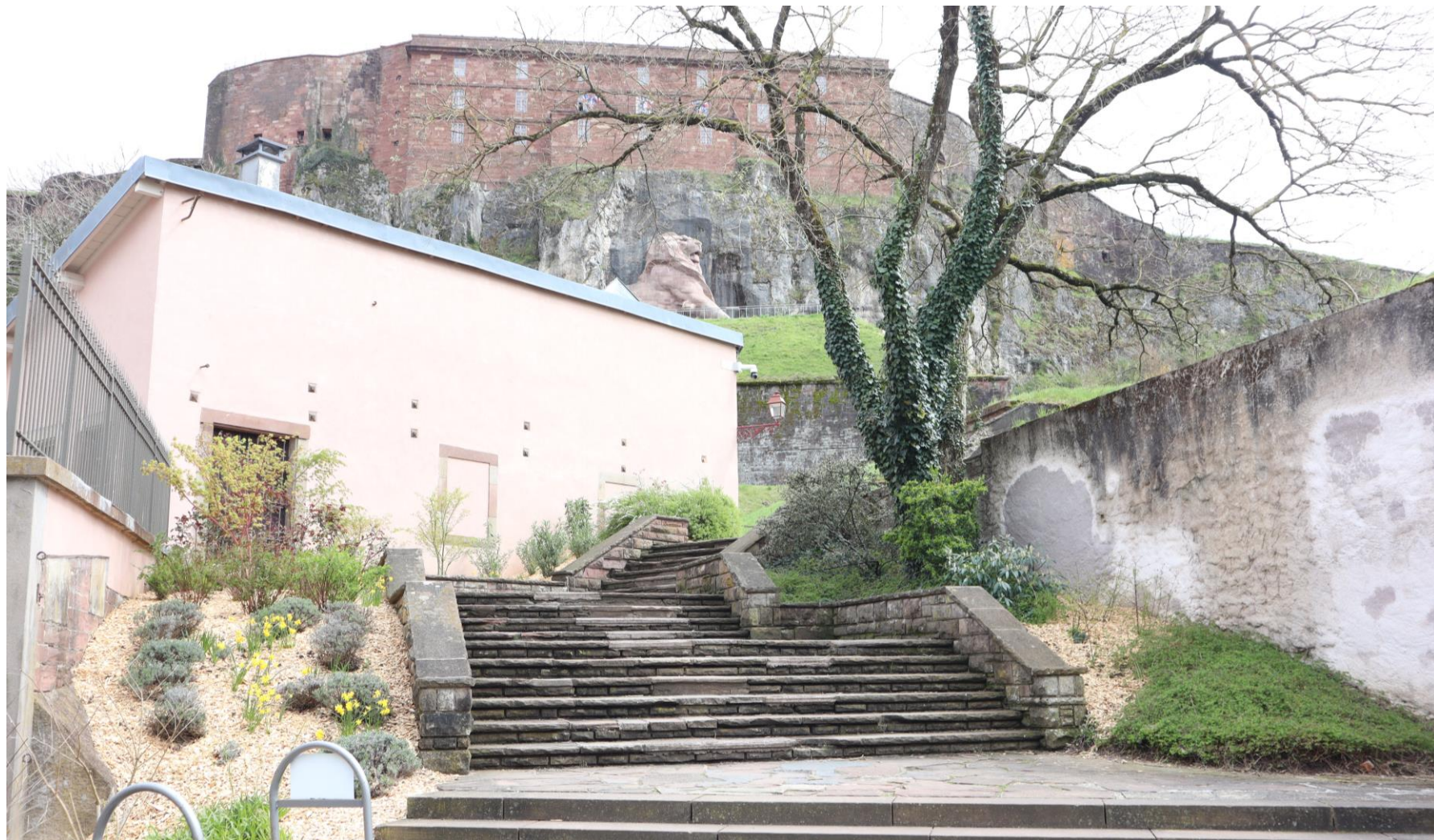
Photos avant les travaux
