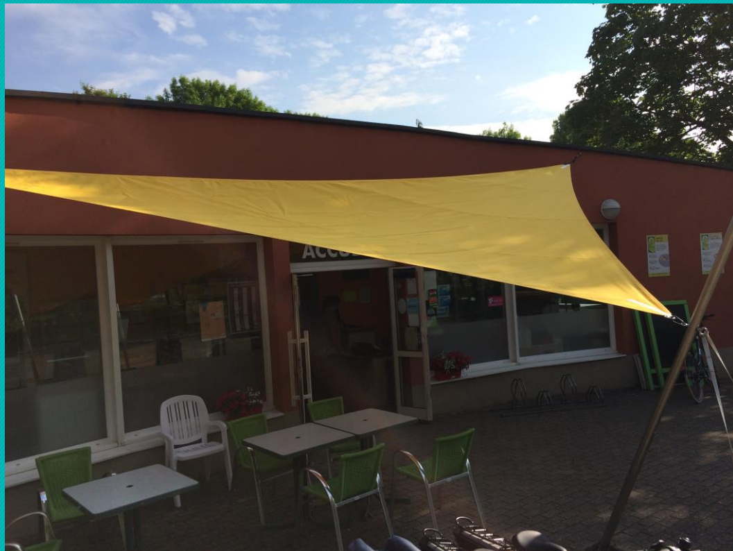
Travaux de l'accueil
