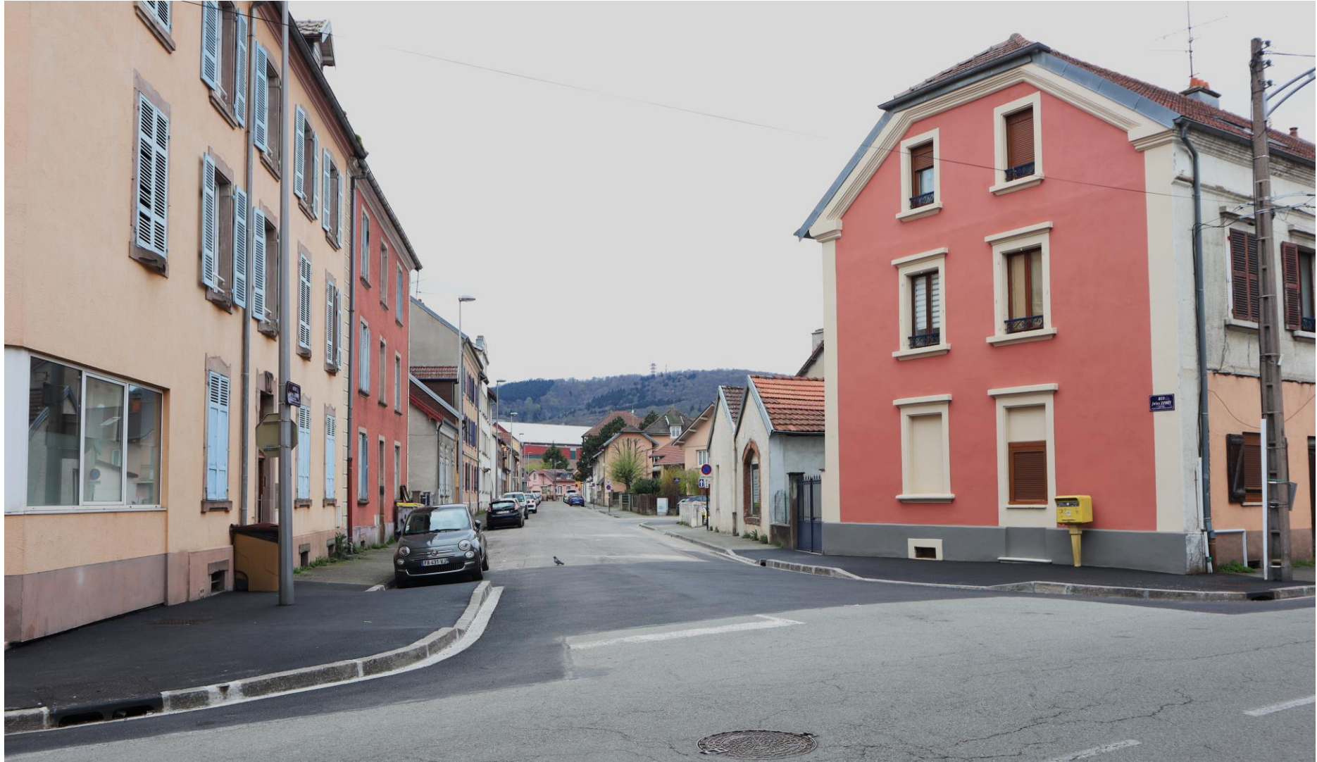
Photo après les travaux
