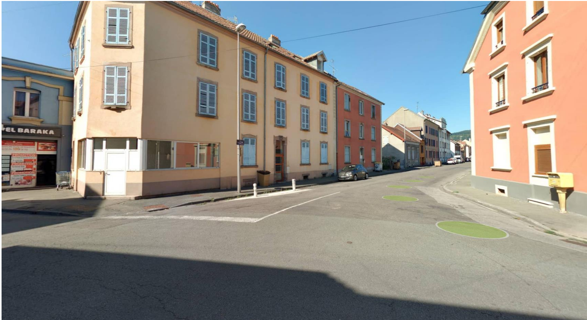
Photo avant les travaux
