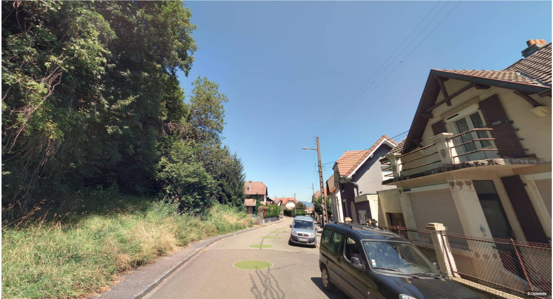
Photo avant les travaux
