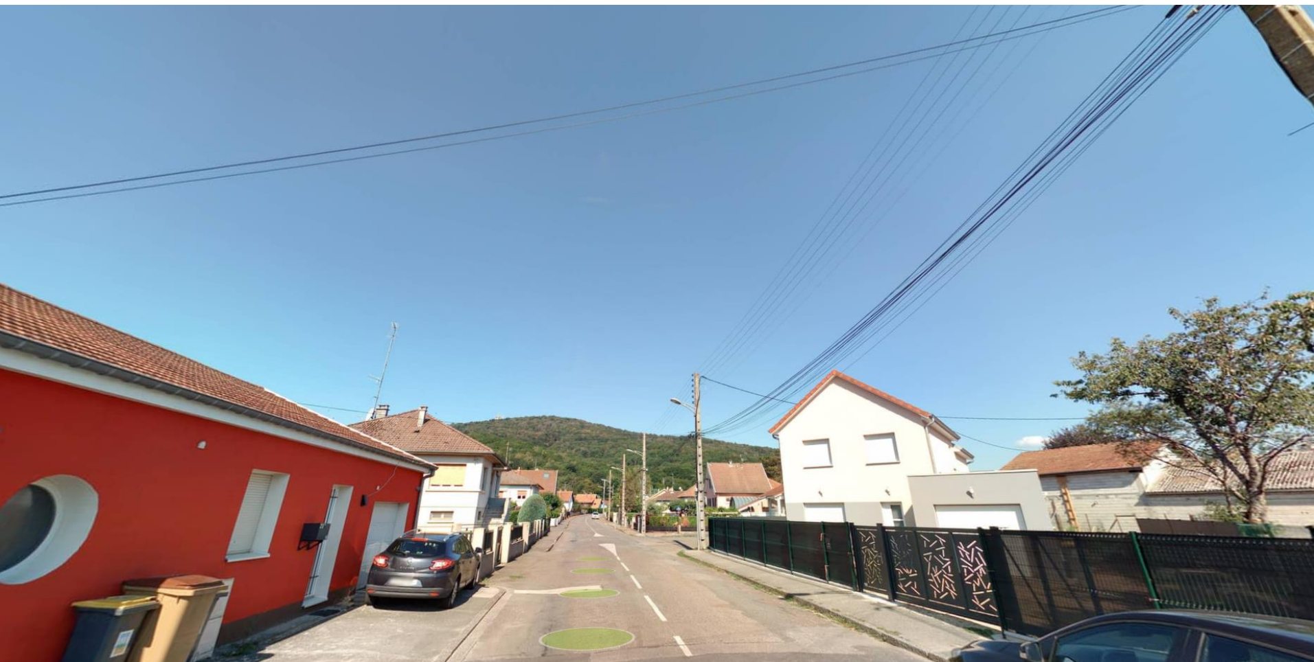
Photo avant les travaux
