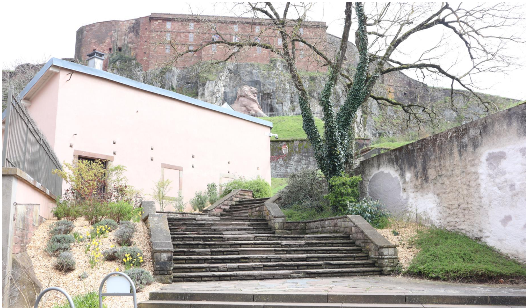
Photos avant les travaux
