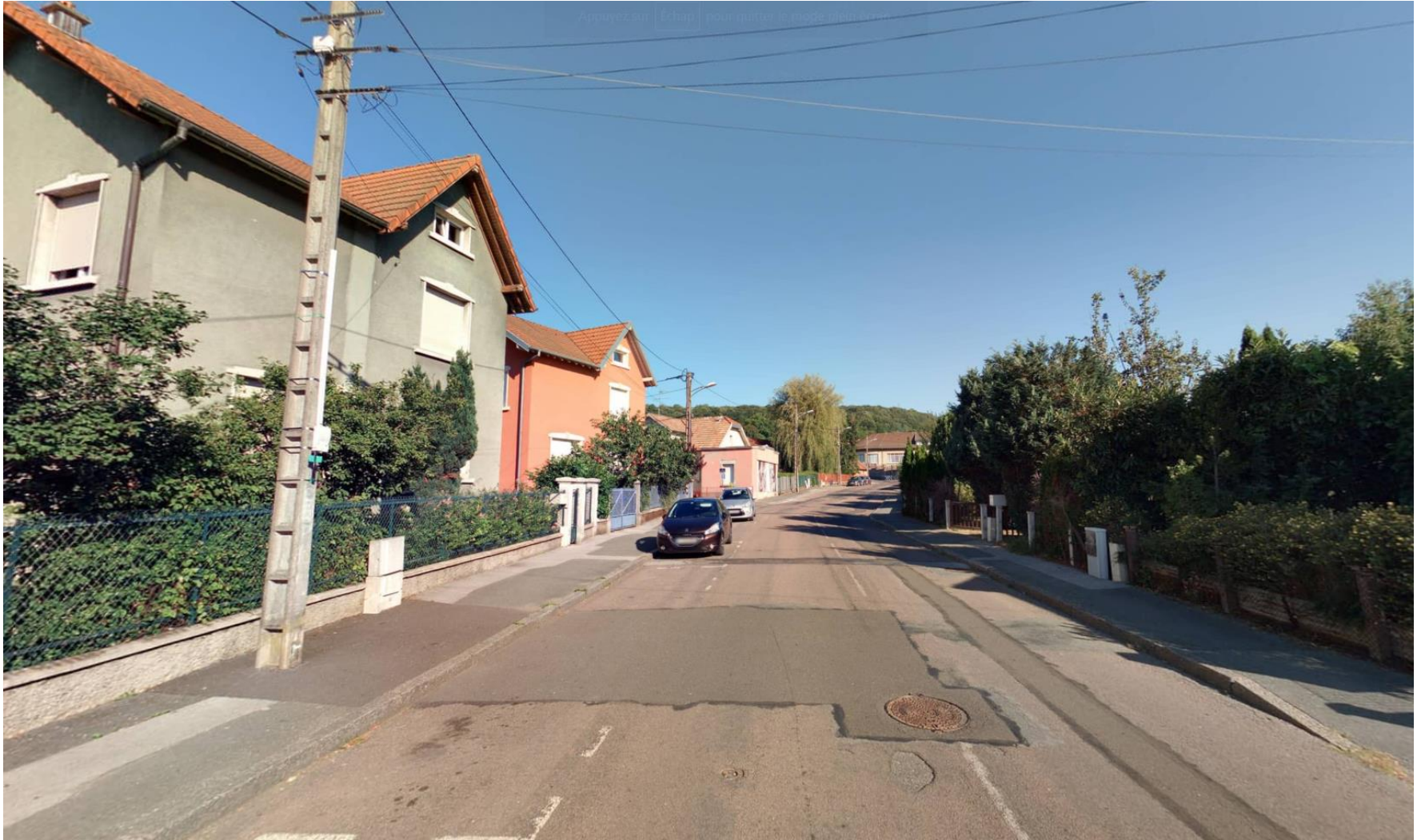
Photo avant les travaux
