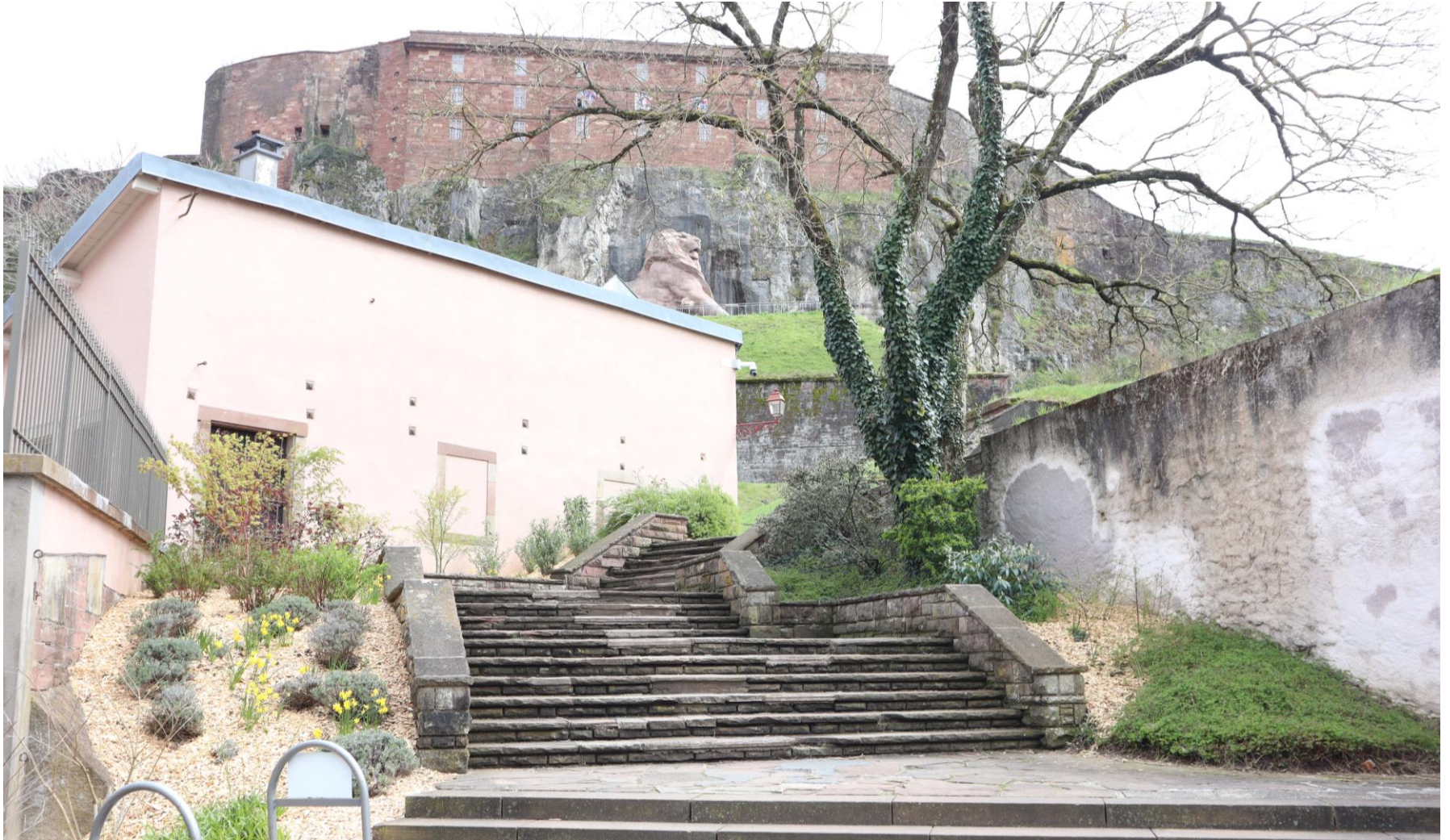
Photos avant les travaux
