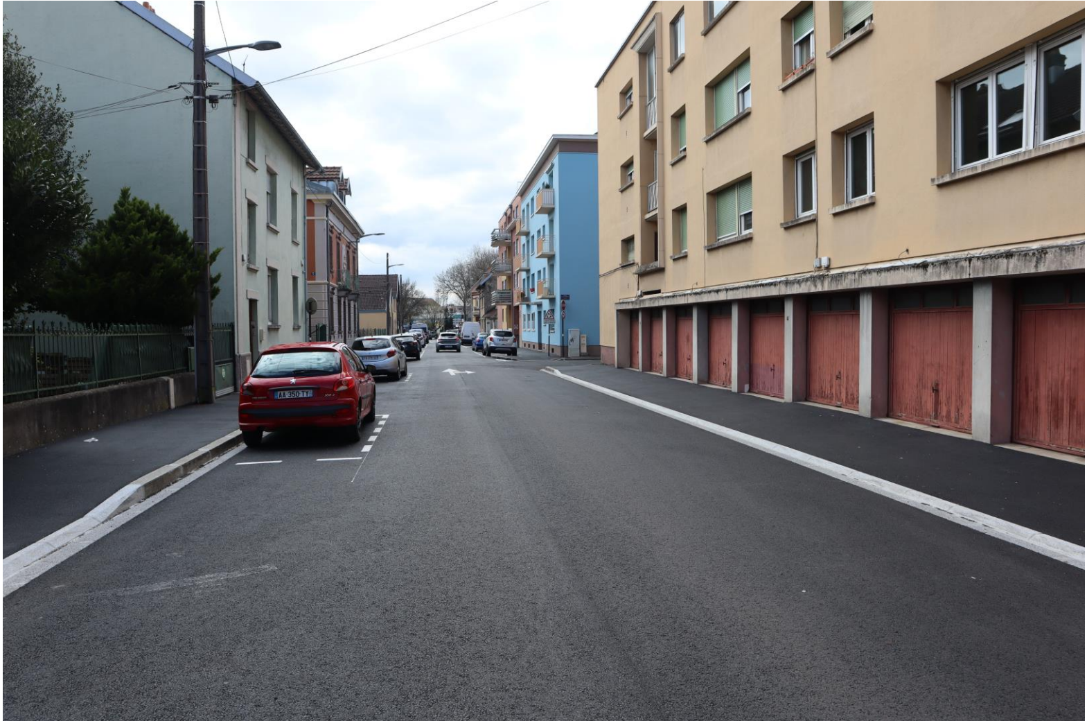
Photo après les travaux
