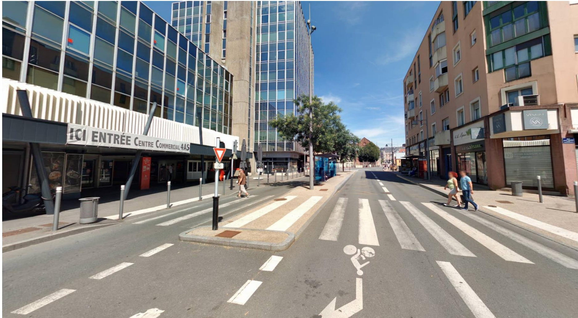
Photo avant les travaux
