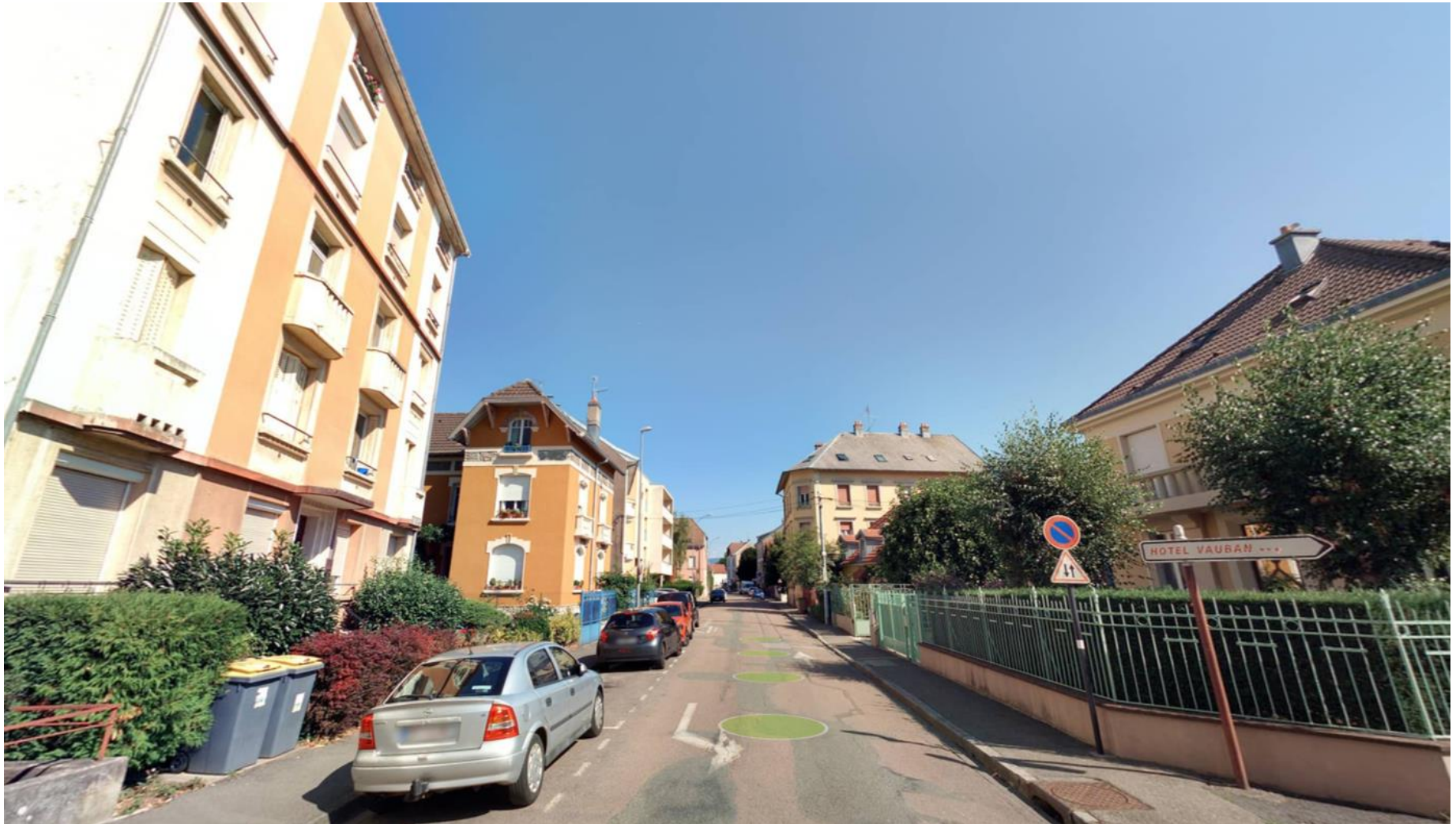
Photo avant les travaux
