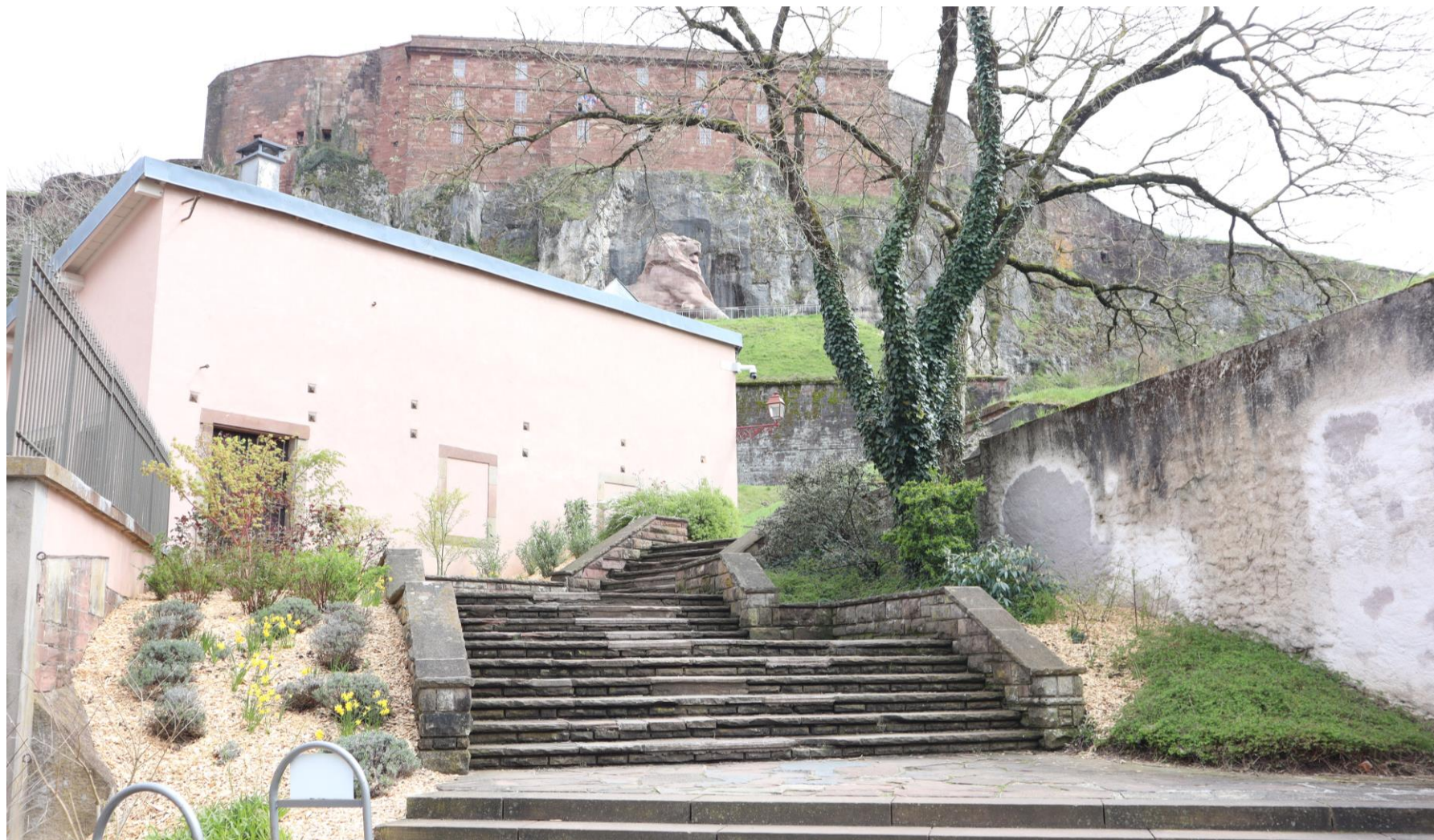
Photos avant les travaux
