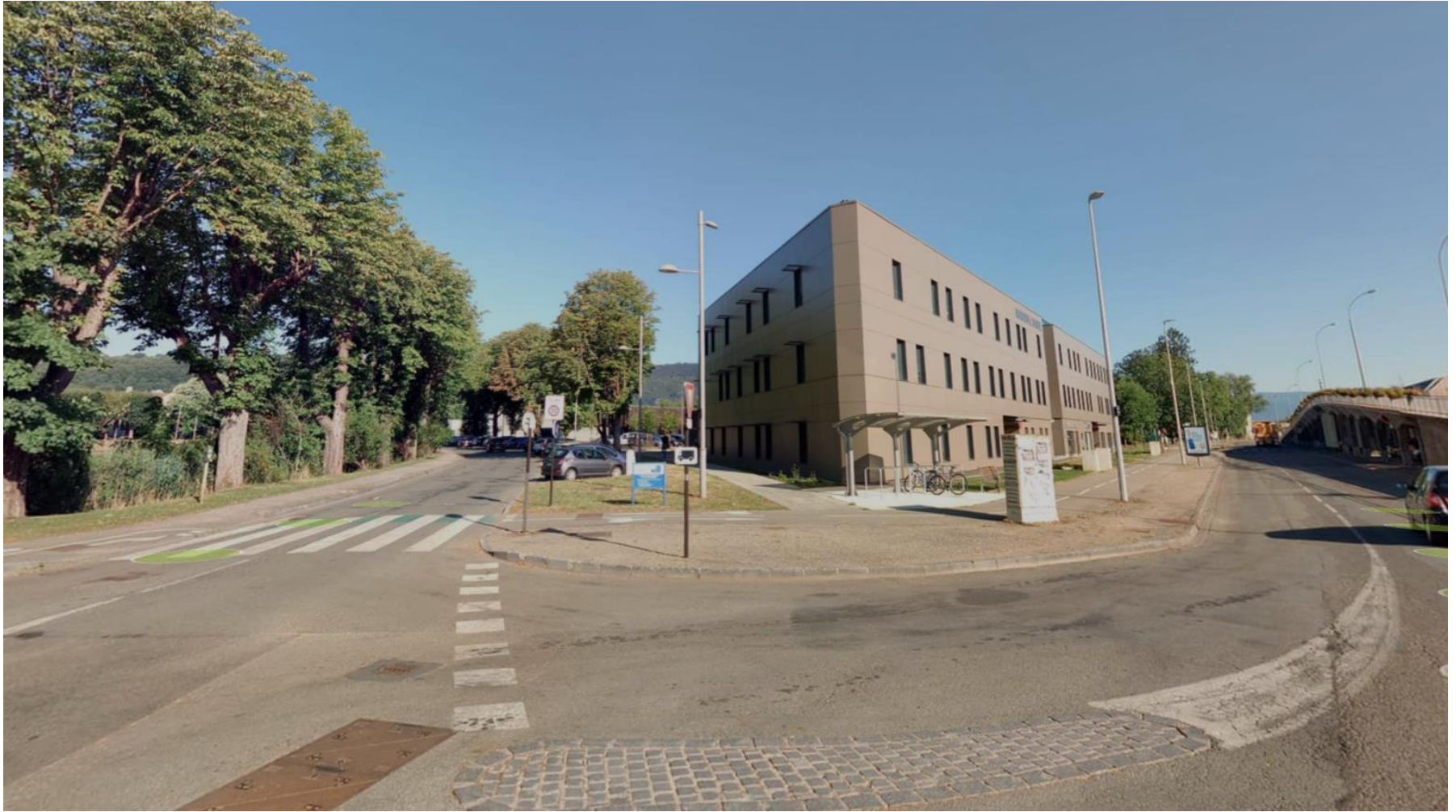
Photo avant les travaux (rue Maurice-et-Louis-de-Broglie)
