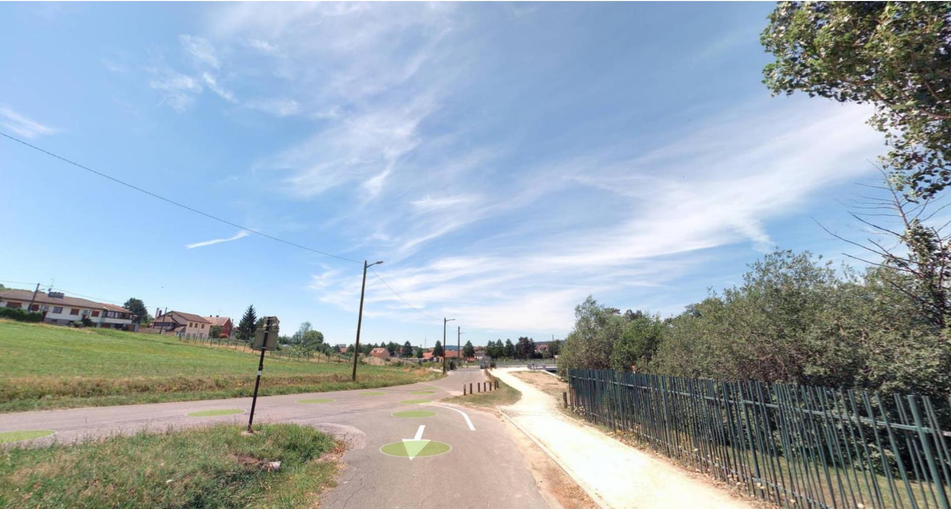
Photos avant les travaux
