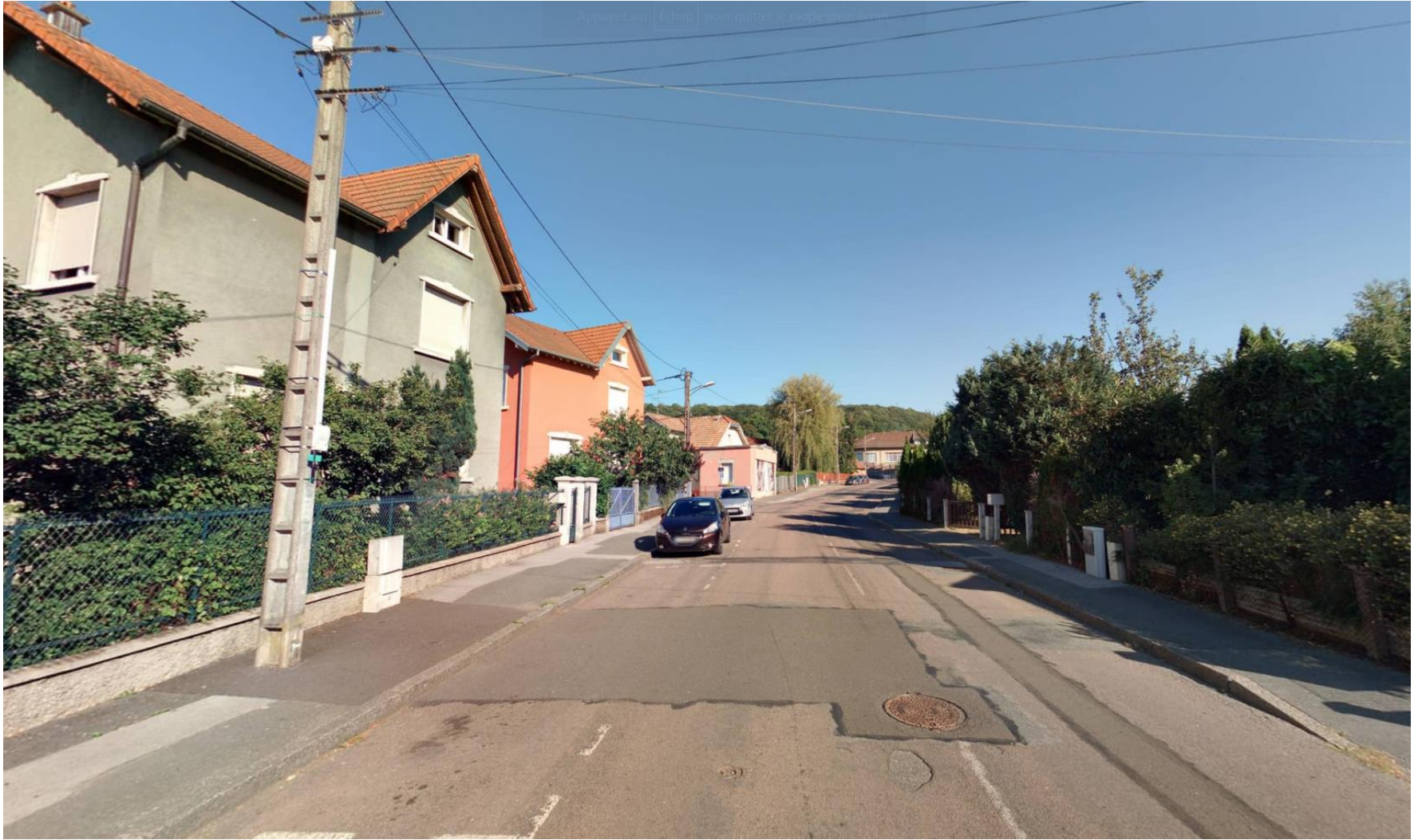
Photo avant les travaux
