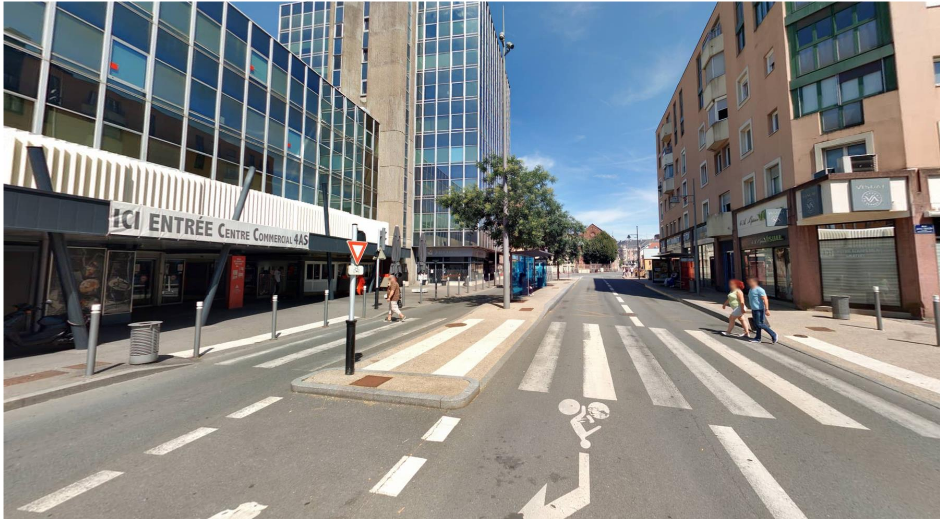
Photo avant les travaux
