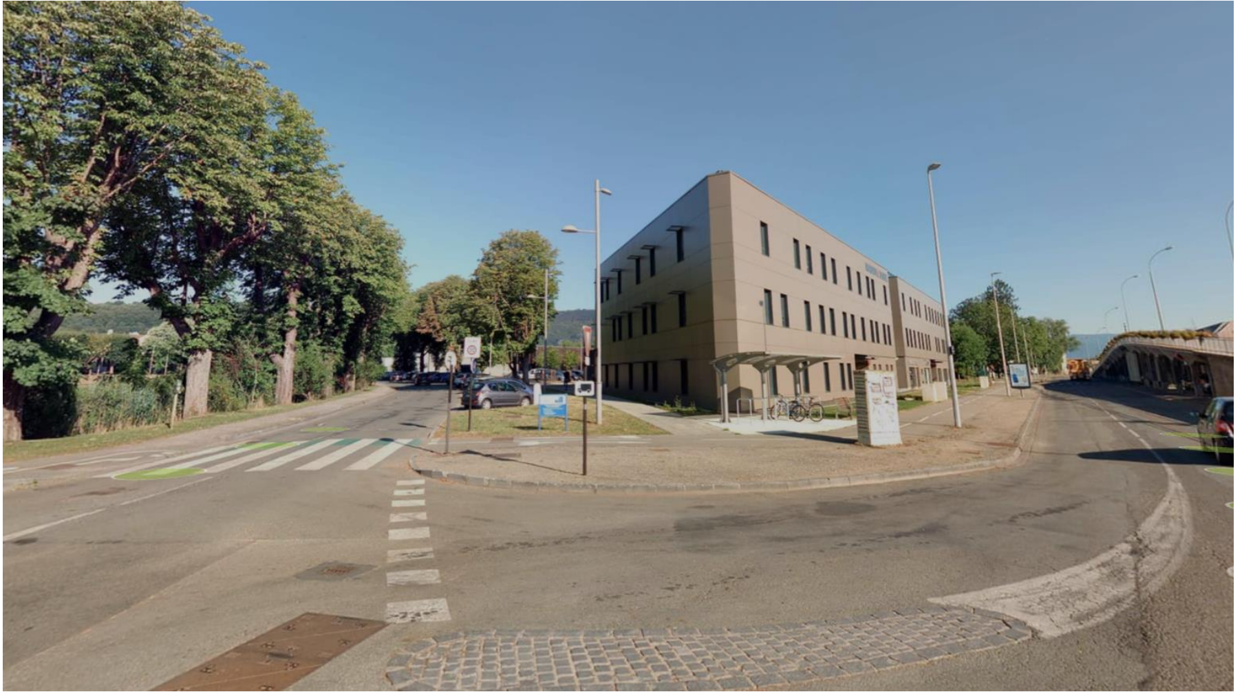
Photo avant les travaux (rue Maurice-et-Louis-de-Broglie)
