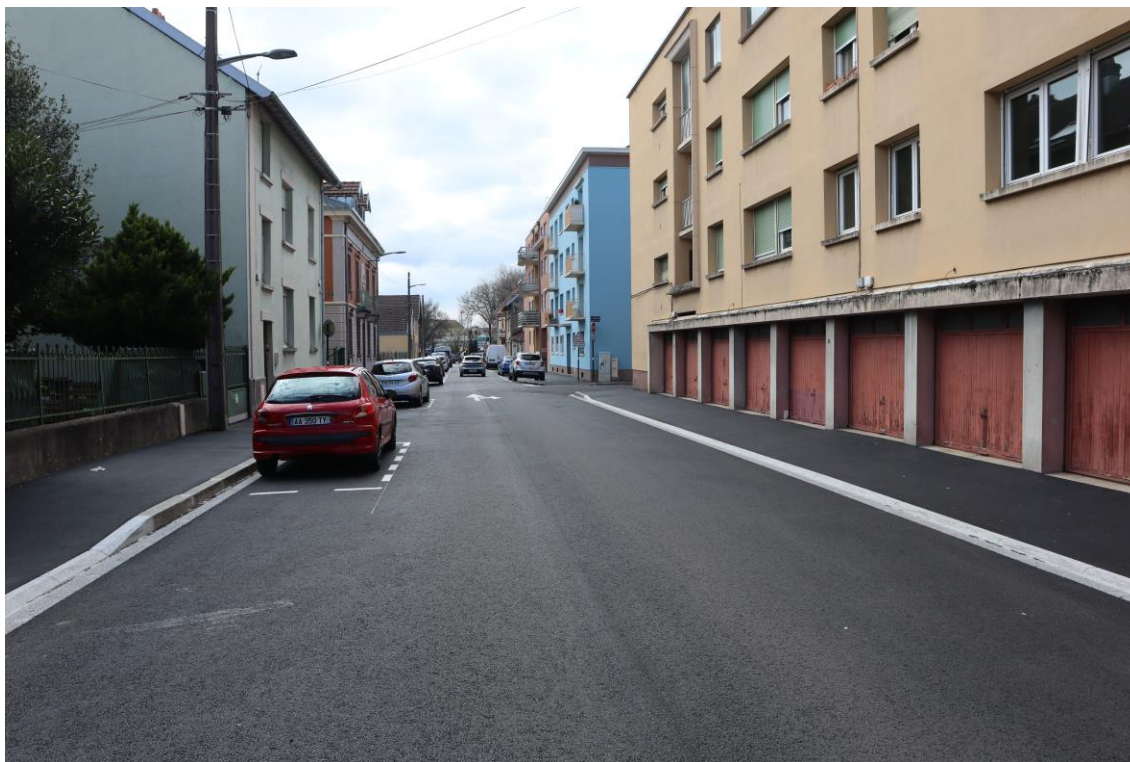
Photo après les travaux
