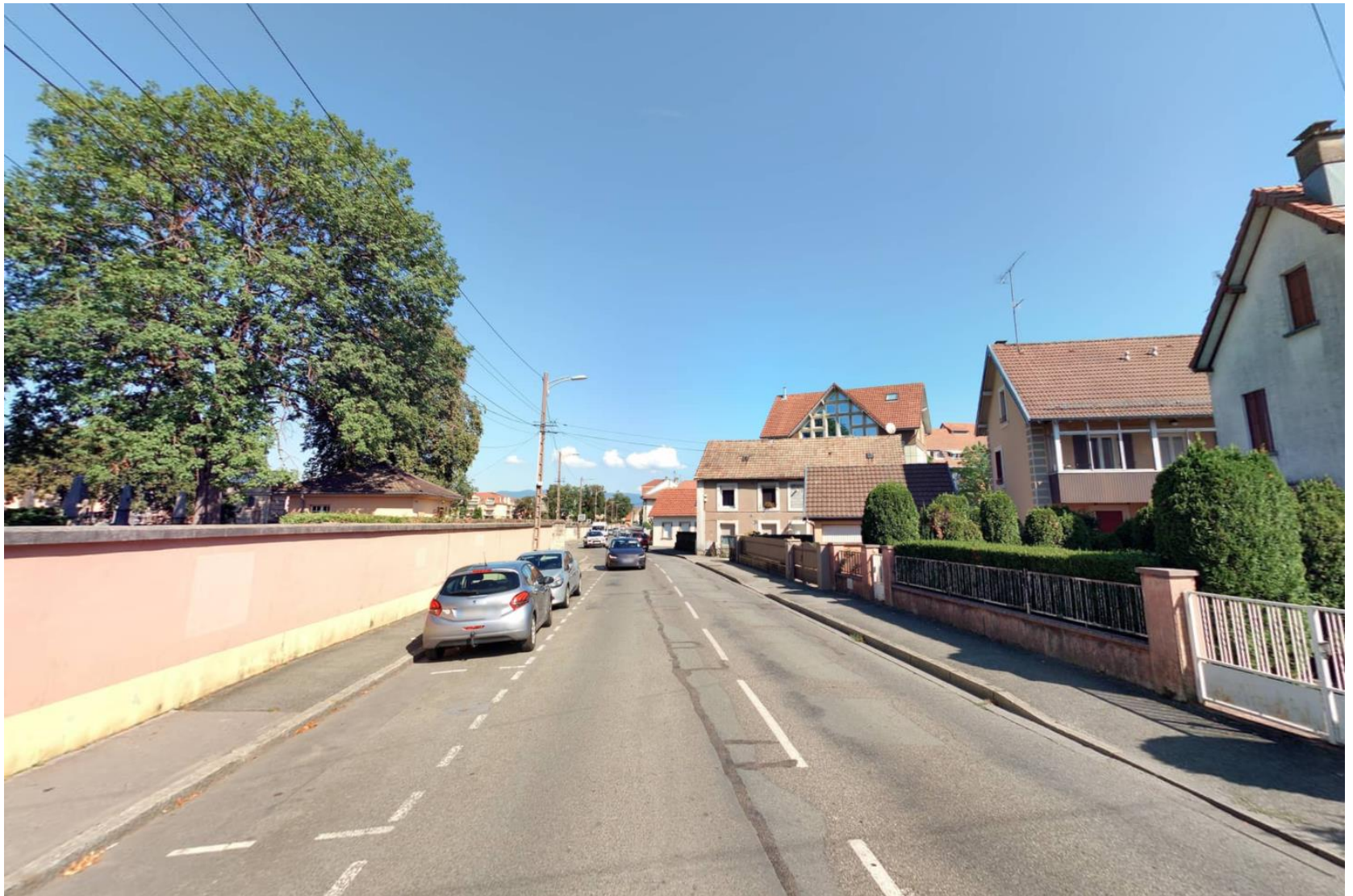
Photo avant les travaux
