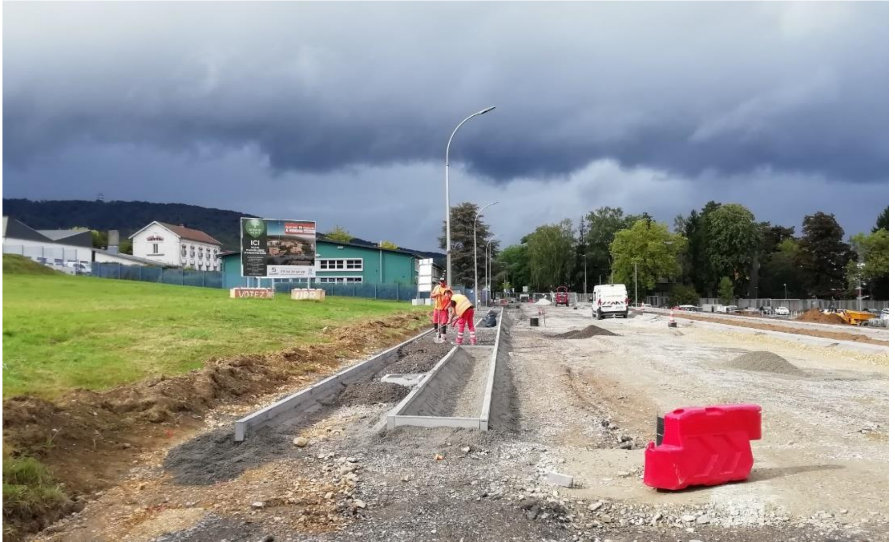
Démolitions, pose de bordures, création d'une bande cyclable, plantations d'arbres et de graminées
