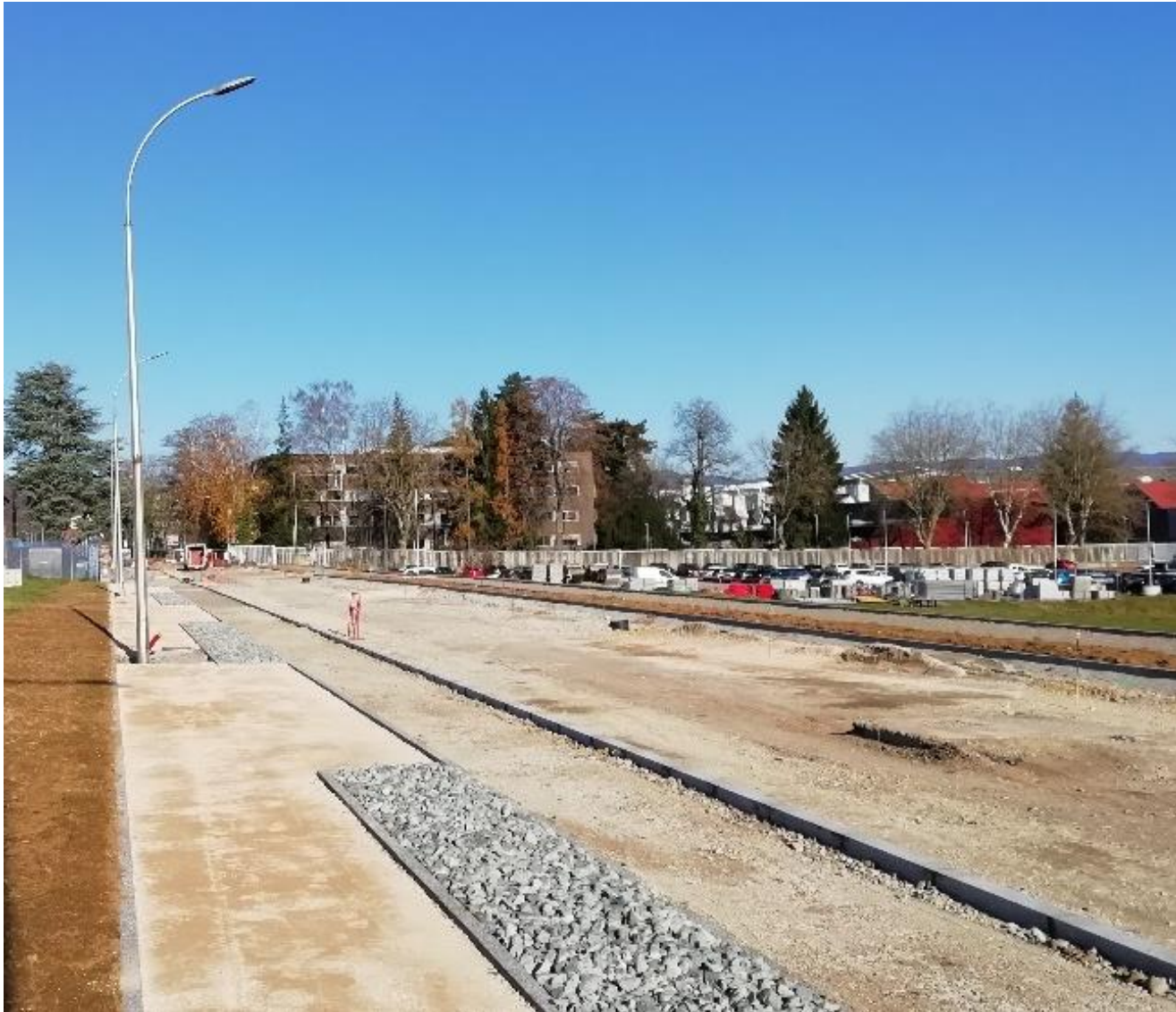
Démolitions, pose de bordures, création d'une bande cyclable, plantations d'arbres et de graminées
