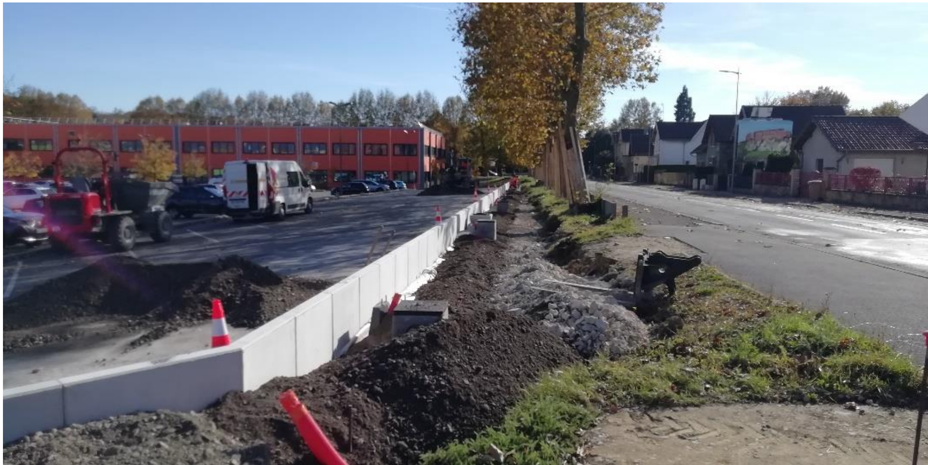
Élargissement du trottoir et mise en place d'un soutènement
