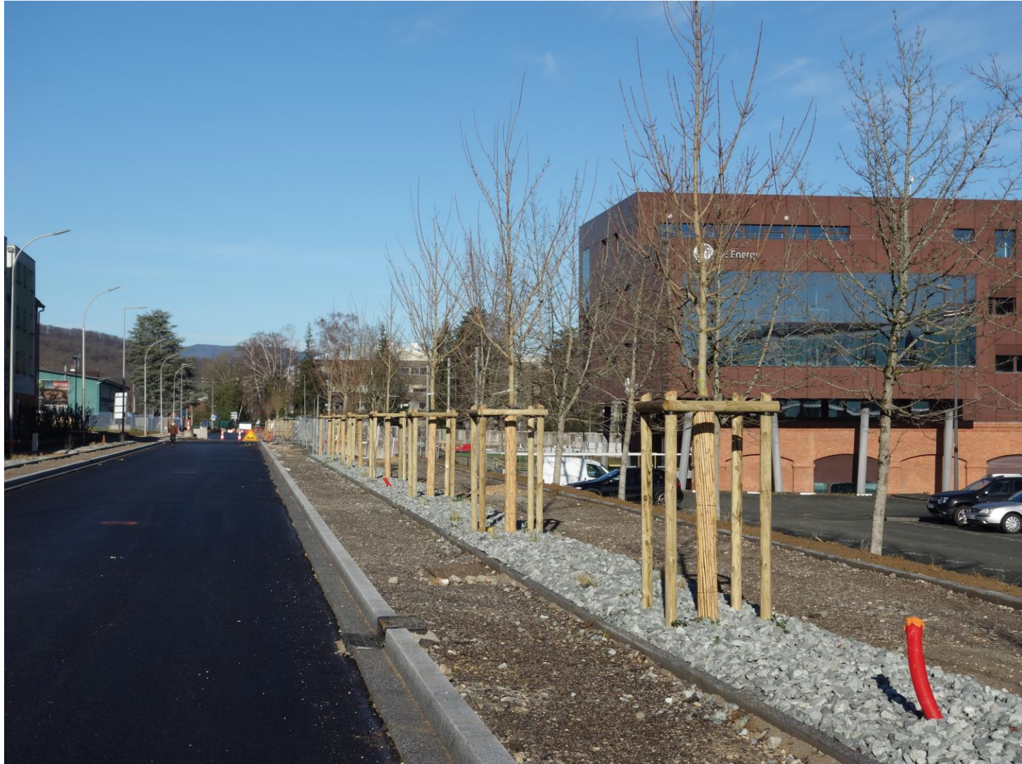
Démolitions, pose de bordures, création d'une bande cyclable, plantations d'arbres et de graminées
