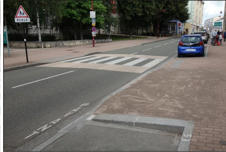
Exemple de réalisation dans le faubourg des Ancêtres Prise de vue après les travaux
