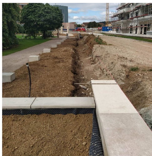
Aménagement d'une liaison douce
