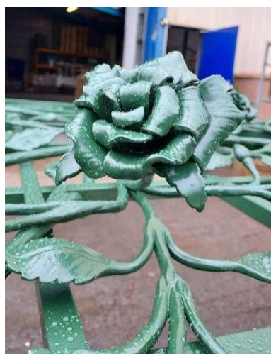
Reprise de ferronnerie
