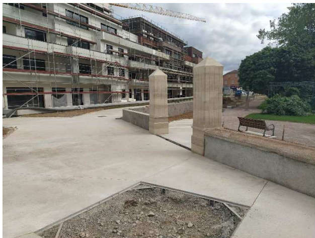
Création d'une entrée Nord-ouest
