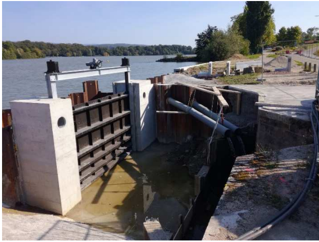
Pose de la vanne de décharge
