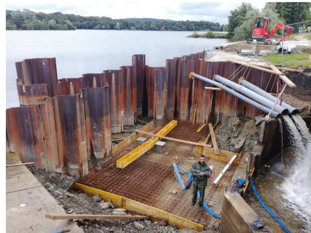
Pose de l'armature
