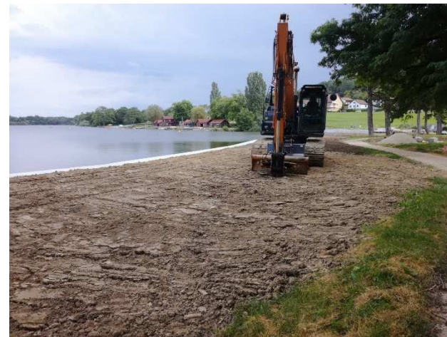
Nivellement de la terre végétale
