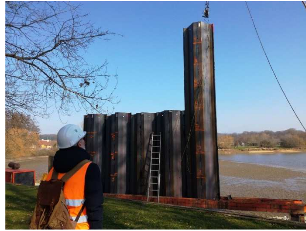
Battage des palplanches
