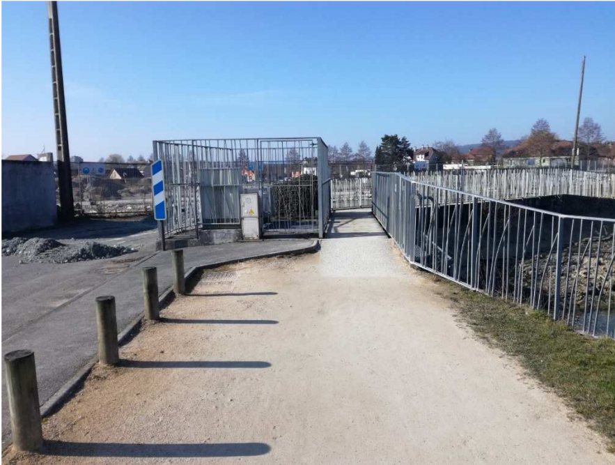
Un cheminement étriqué au niveau de la vanne.
