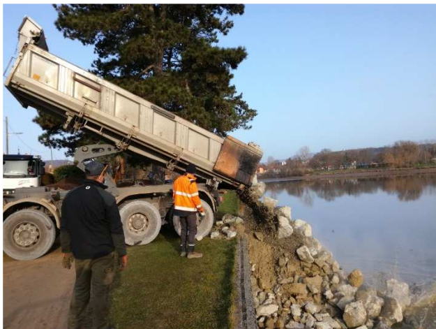
Création des rampes d'accès
