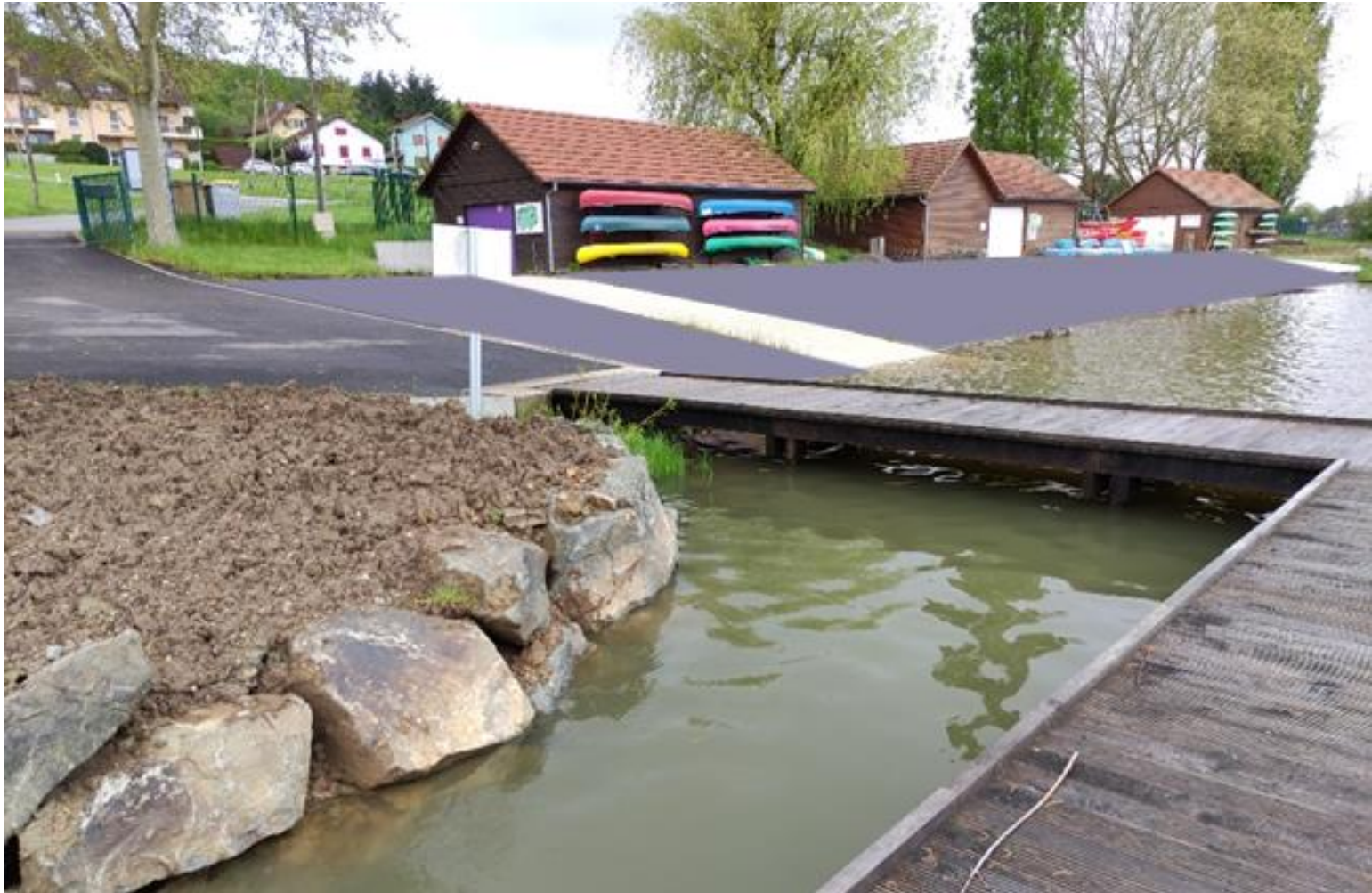
Projection Accès à la plage revêtu d'enrobés
