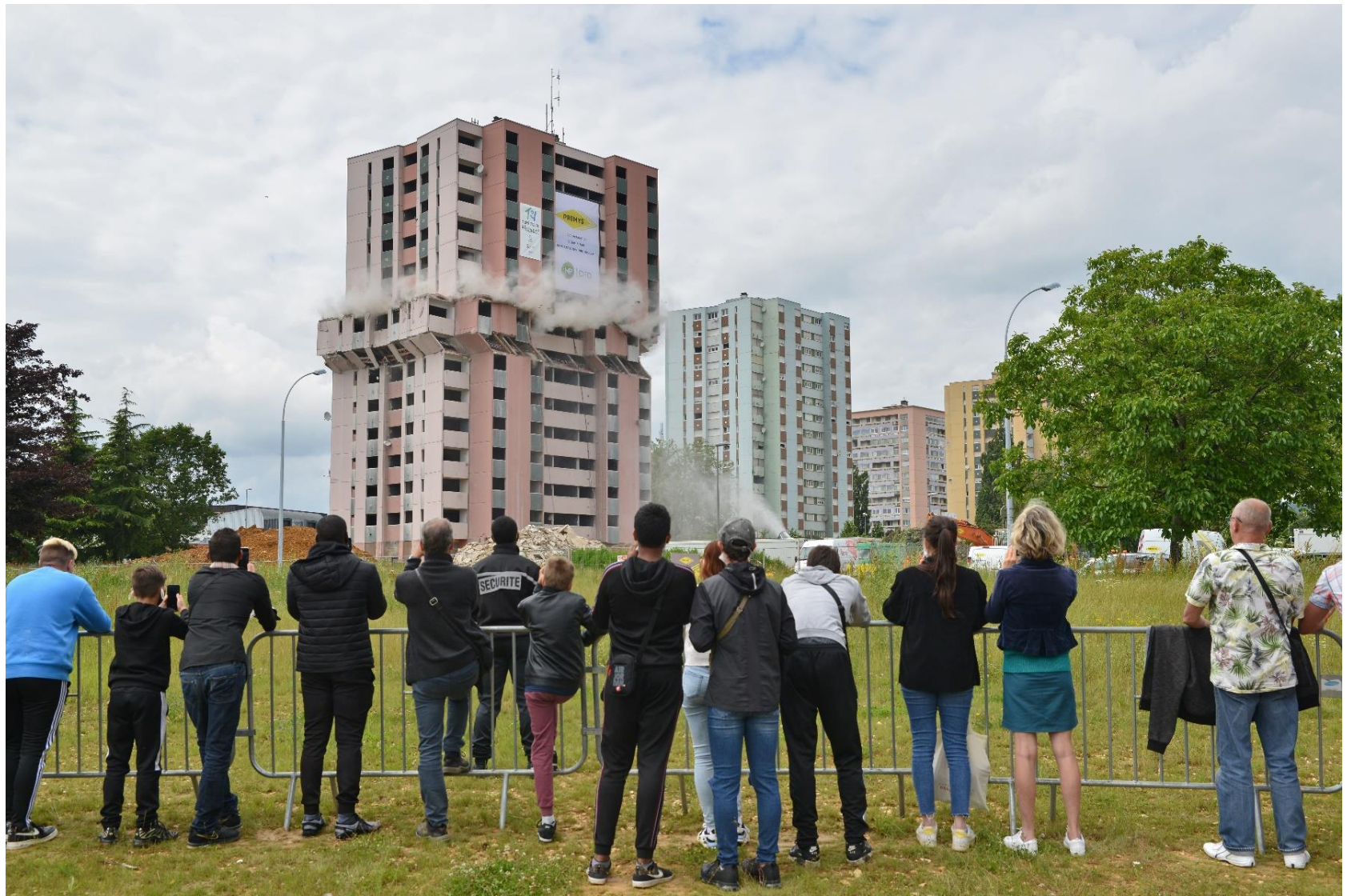
La démolition de la tour du 3 rue Henri-Dorey, le 1 er juillet 2021
