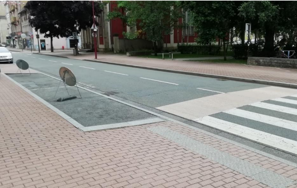
Exemple de réalisation dans le faubourg des Ancêtres Prise de vue avant les travaux
