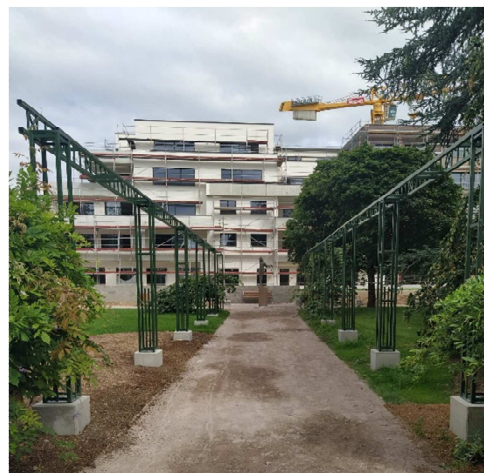
Remplacement de l'ancienne pergola
