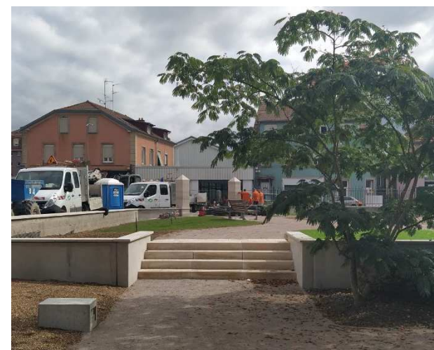
Création d'une entrée Nord-Est
