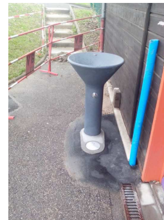
Miotte Forges – Installation d'une fontaine d'eau potable aux abords de l'Etang
