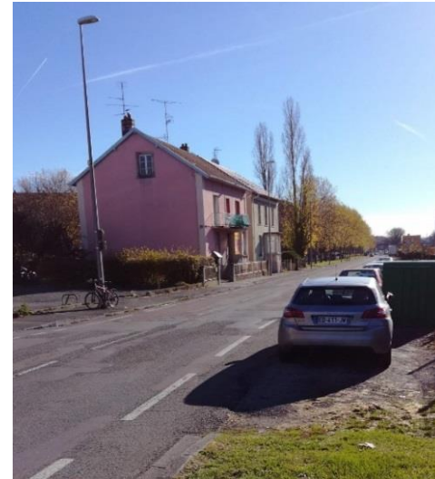
Stationnement sur accotement Revêtement de chaussée vieillissant
