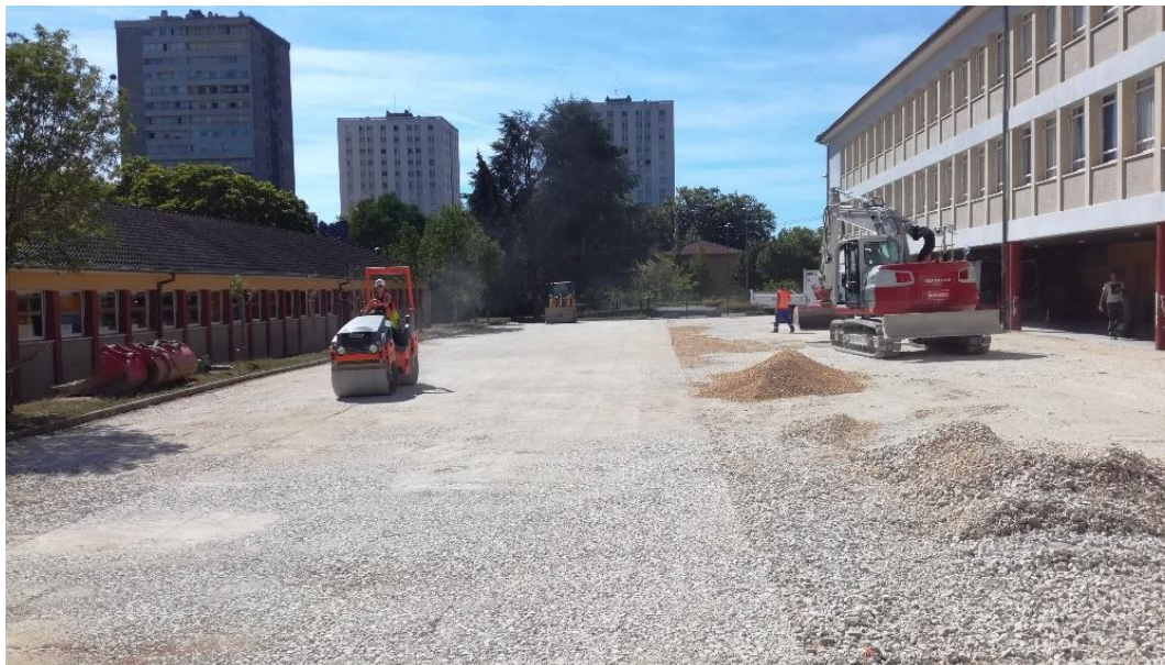
Exemple de réfection de la cour de l'école Dreyfus-Schmidt Juillet 2018
