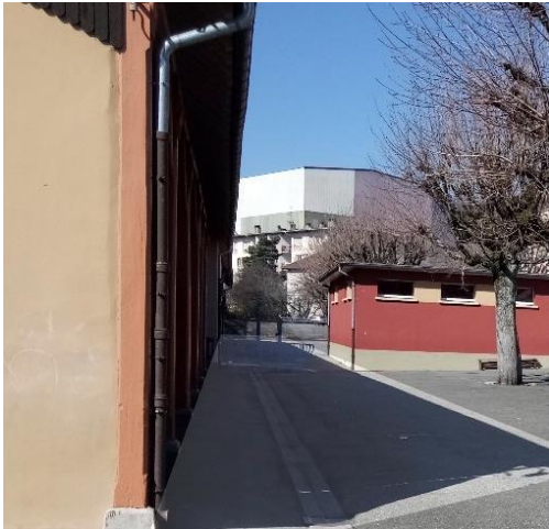
Dénivellation trop importante pour les déplacements des enfants
