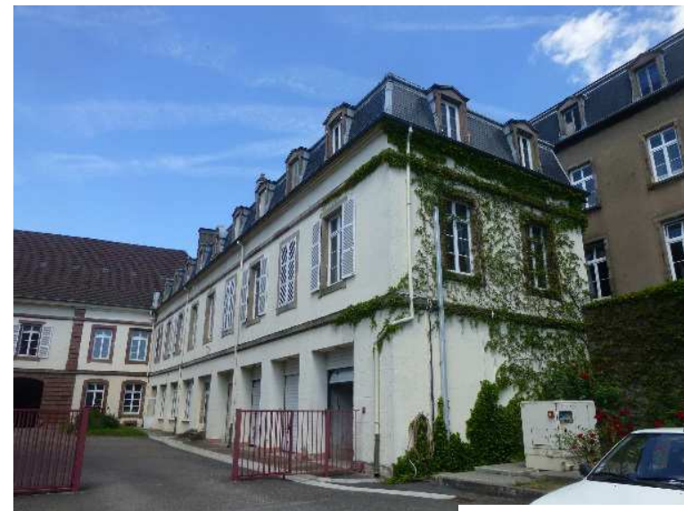
Cour intérieure bâtiment 005
