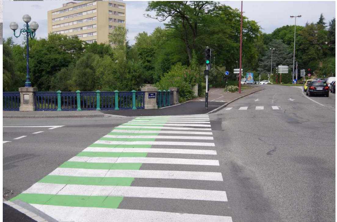
Traversée du Pont du Magasin
