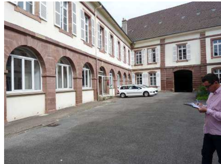
Cour intérieure bâtiment 005
