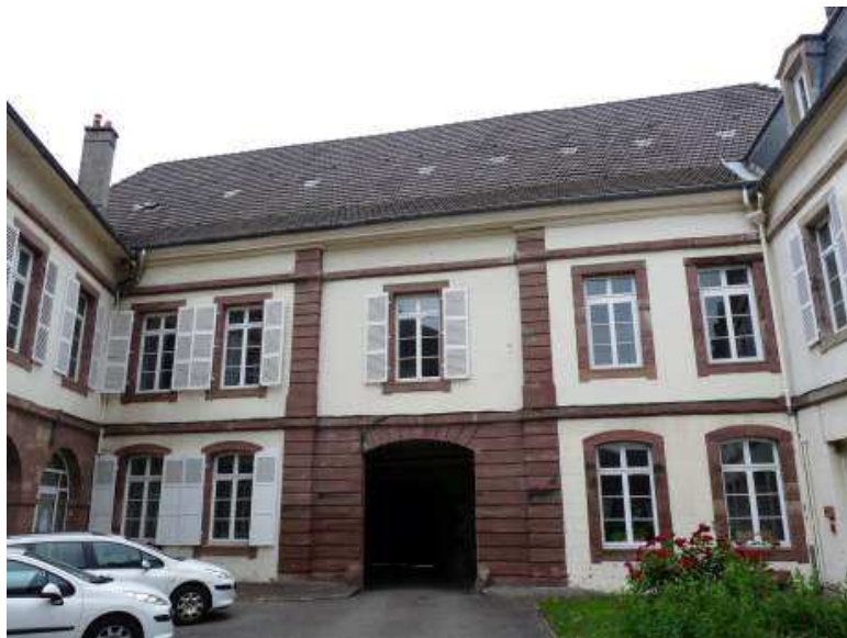
Cour intérieure bâtiment 004
