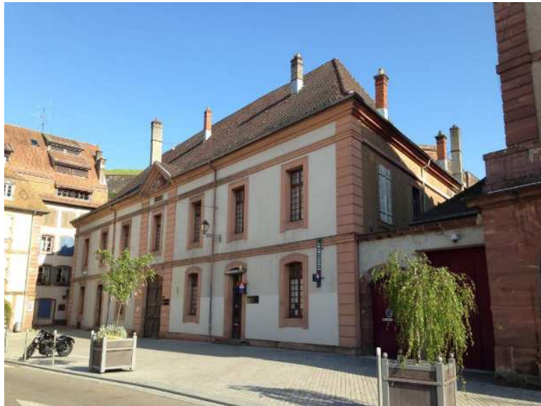
Place de l'Arsenal bâtiment 004
