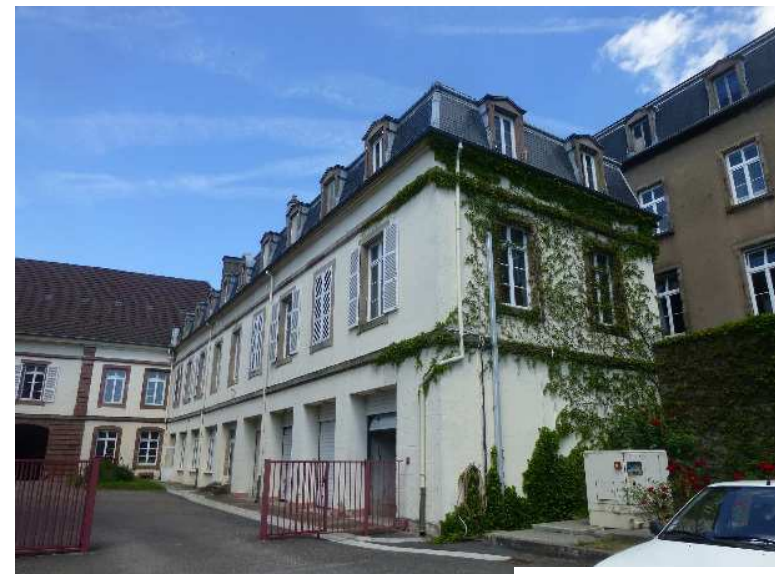
Cour intérieure bâtiment 006
